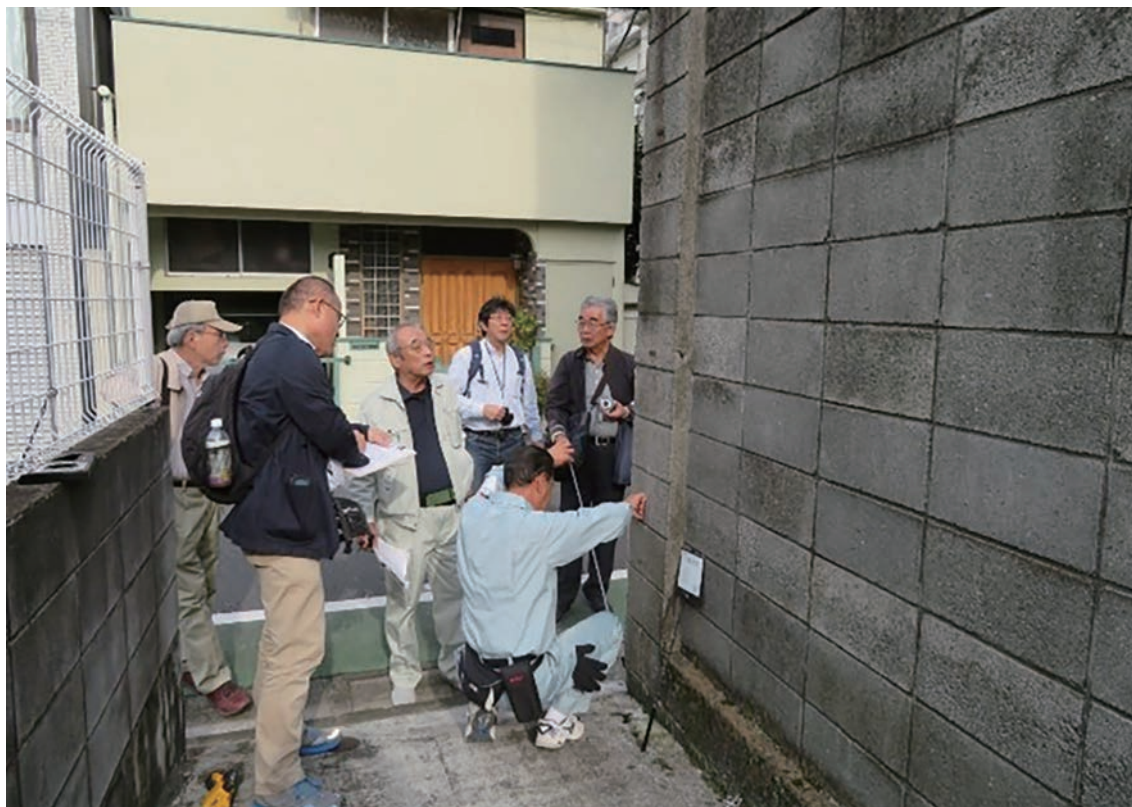
図2 ブロック塀の無料診断
